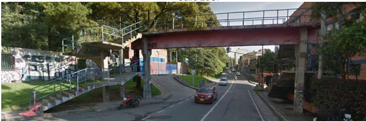
Figura 30 - Puente Peatonal a reemplazar por paso a nivel. Avenida Circunvalar por Calle 26C.
