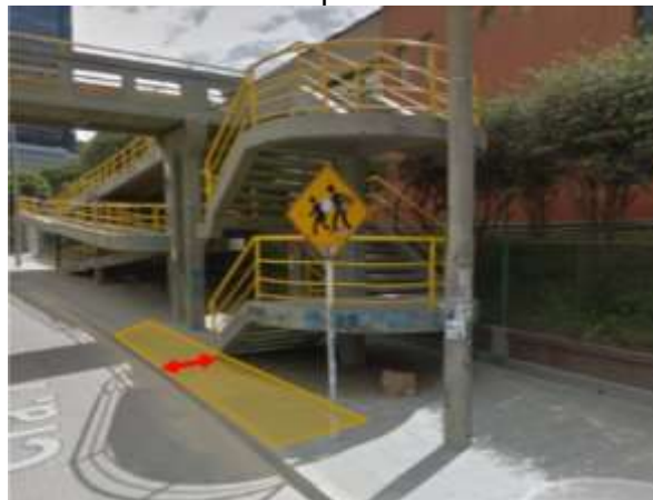
Figura 17 - Puente peatonal con poco espacio público de andén para circulación peatonal.
