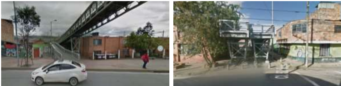
Figura 32 - Imágenes de zonas de acceso a puentes peatonales
